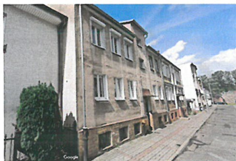
Budynek mieszkalny wielolokalowy przy ul. Chmielna 10, 11 – aktualny stan
