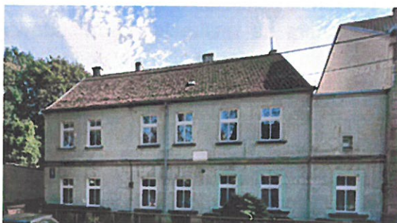
Budynek mieszkalny wielolokalowy przy ul. Chmielna 10, 11 – aktualny stan
