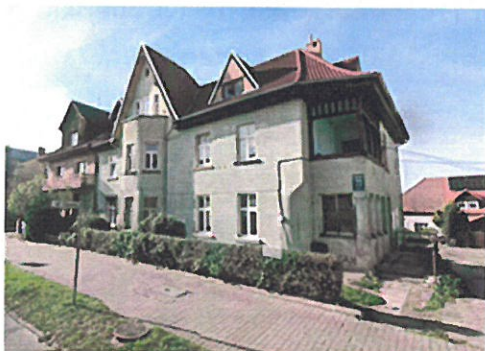
Budynek mieszkalny wielolokalowy przy ul. Chmielna 10, 11 – aktualny stan
